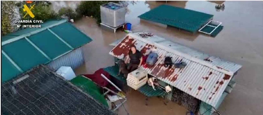
La gota fría también ha causado estragos en Málaga, dejando numerosas personas atrapadas en sus viviendas
