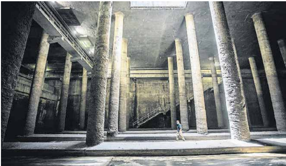
El depósito del parque Joan Miró. con una capacidad de 55.000 metros cúbicos
