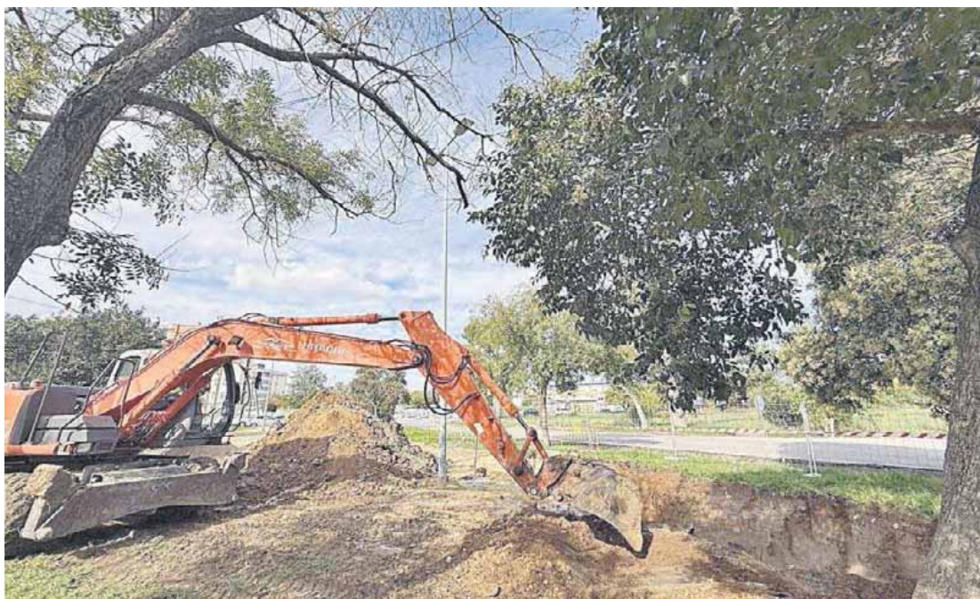
Intervención en el colector de San Enrique.
